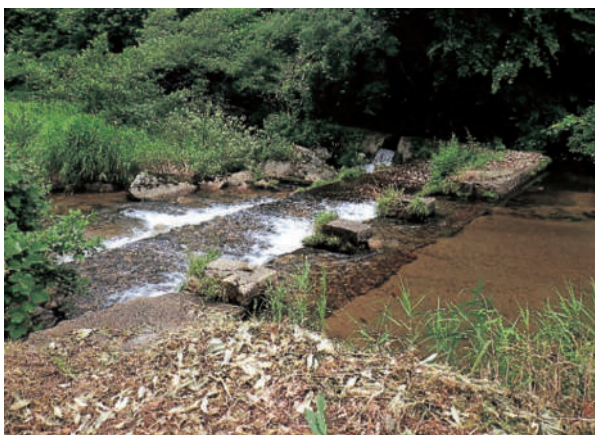
統廃合により廃止となる頭首工
