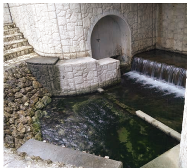
地下ダム放水状況
