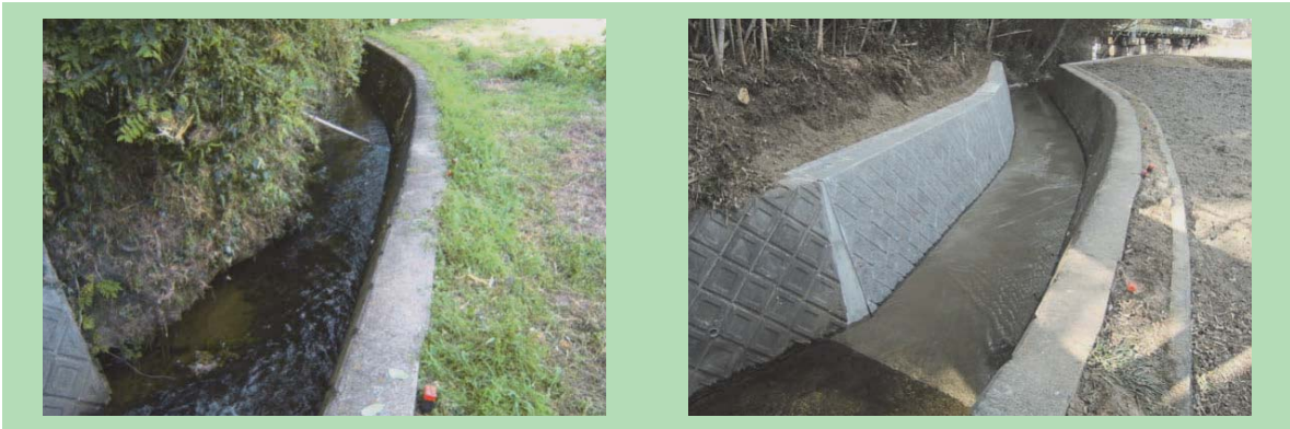
土水路の改修 (法止めを兼ねた水路の改修)
