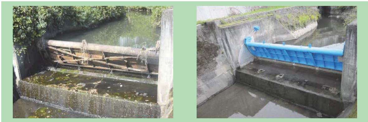
扉体の分解補修
