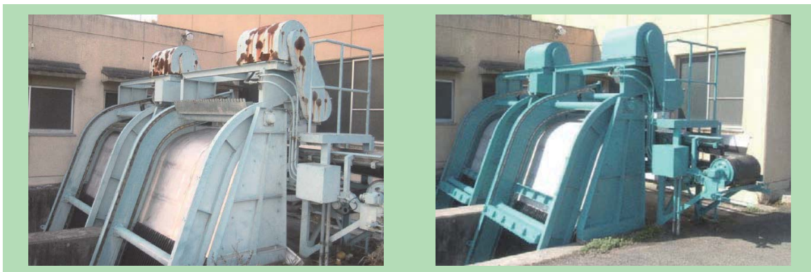
除塵装置の分解補修、塗装
