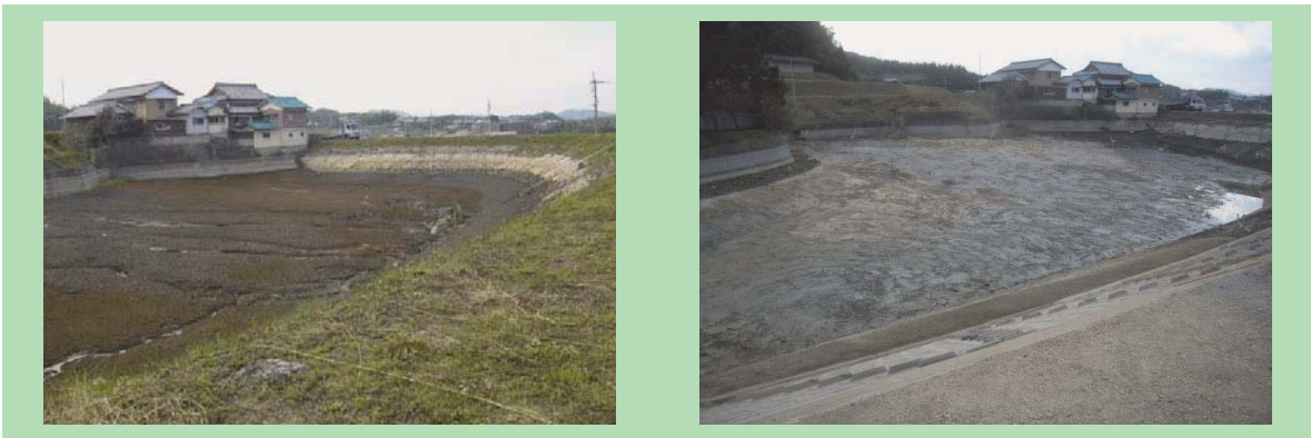
堆積土砂の浚渫
