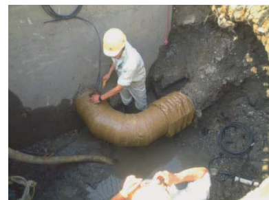
管水路 (漏水箇所) の補修
