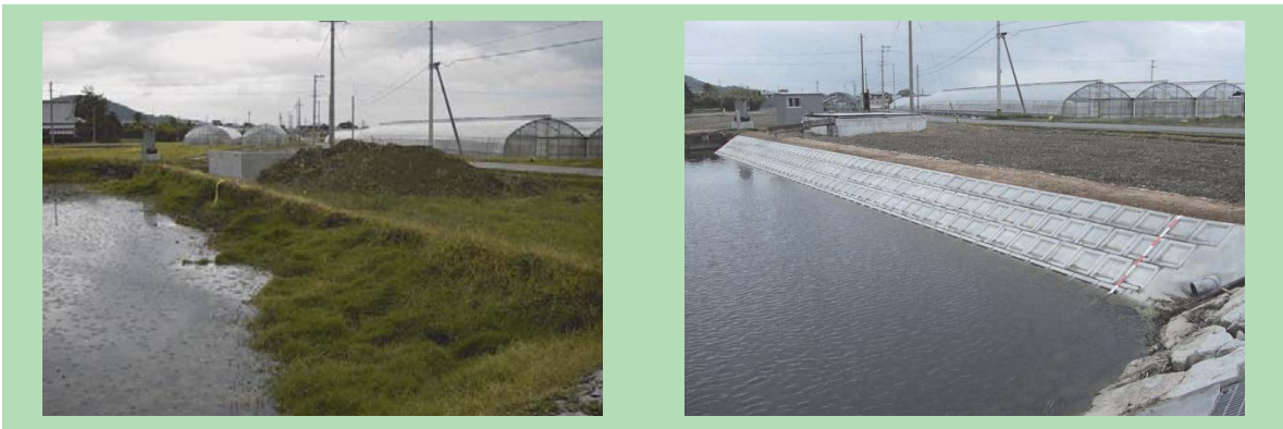
堤体(護岸)の補修
