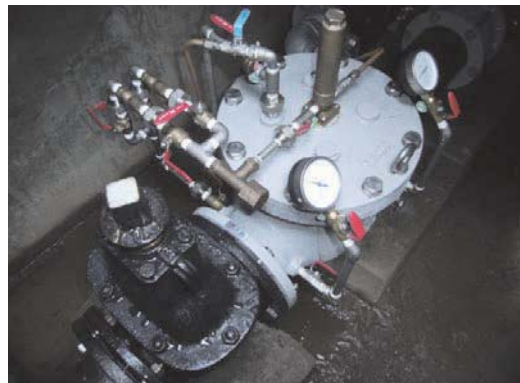
減圧弁の補修
