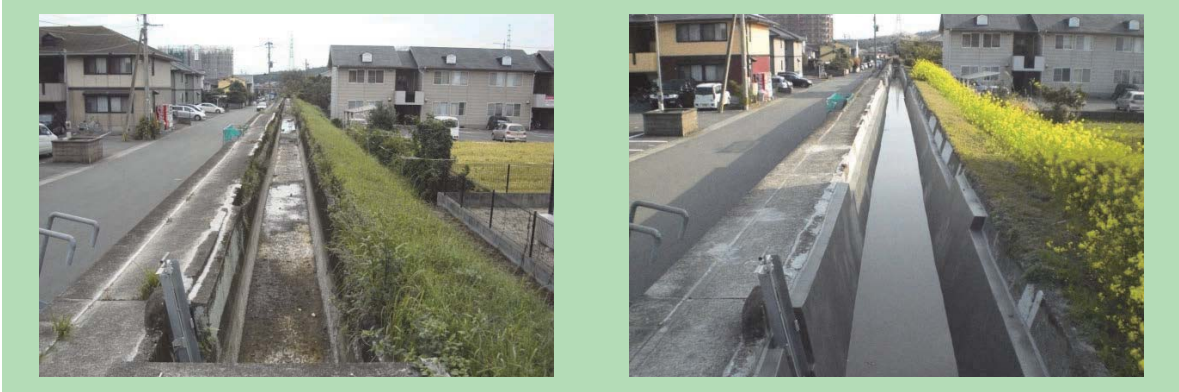
水路の目地補修及び表面被覆工
