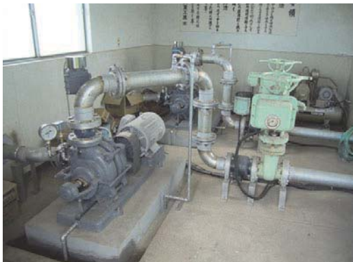
加圧ポンプの更新
