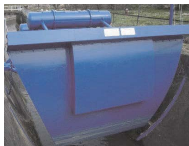
分水工 (水位調整ゲート) の塗装
