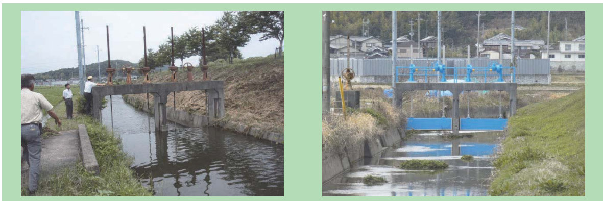
巻上機の整備補修
