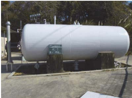
圧力タンクの補修、塗装
