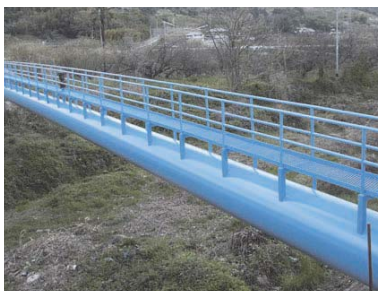
管水路 (水管橋) の補修・塗装
