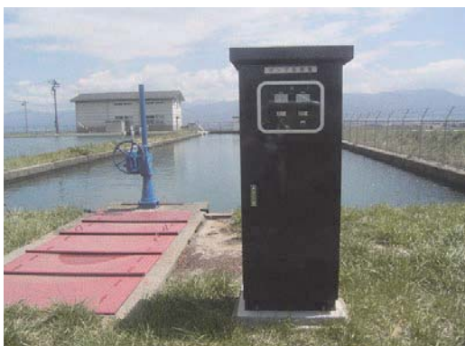
ポンプ制御盤の更新
