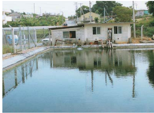
ファームポンド 漏水部の補修
