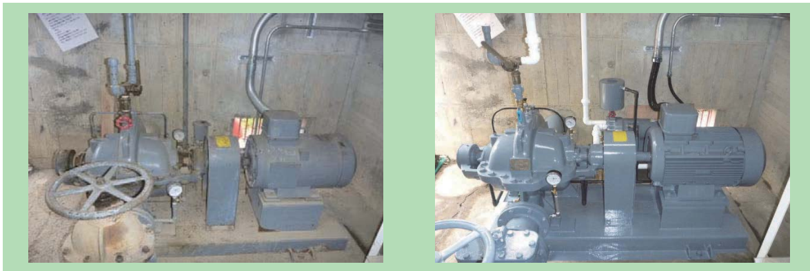
ポンプの整備補修、電動機交換
