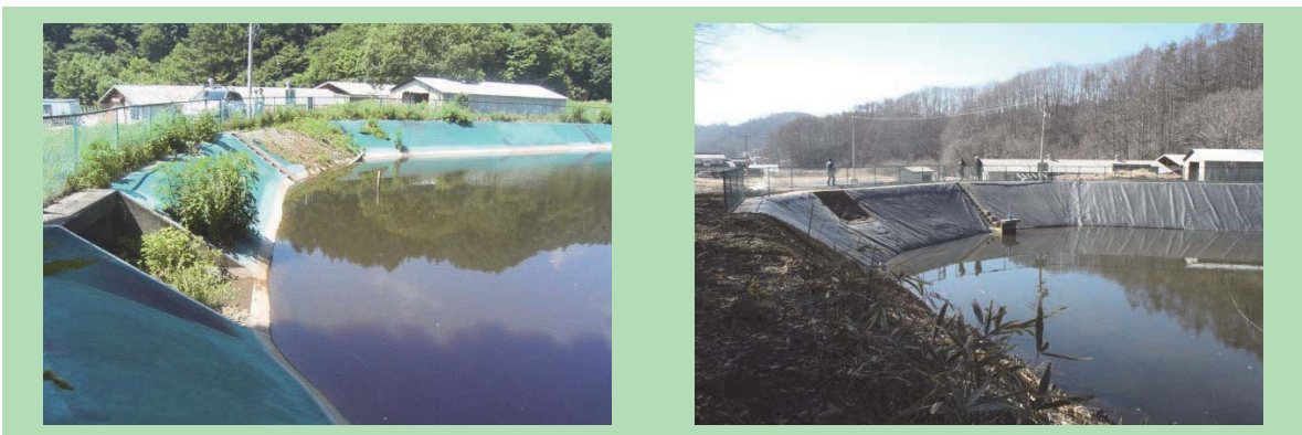
堤体・遮水シートの張り替え
