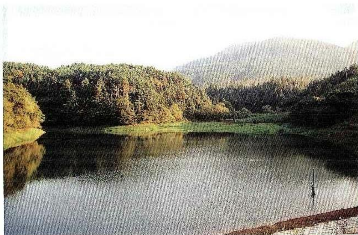
もこり ながたに 底樋の一部が見える大谷池
