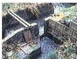
大堤池に分水するところ
