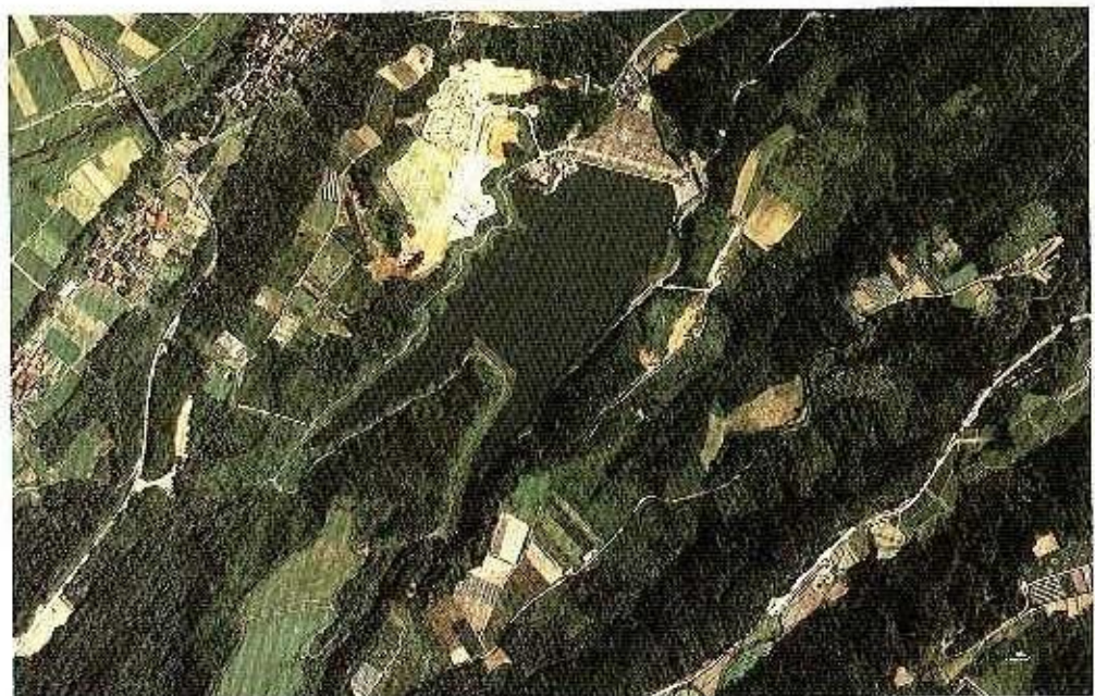
④ 上空から見た西高尾ダム
