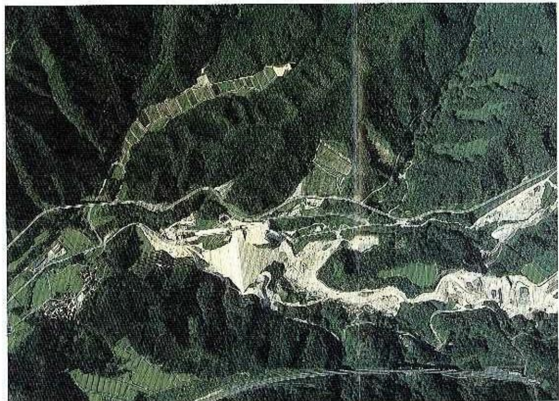
上から見た建設中の下岐屋ダム
