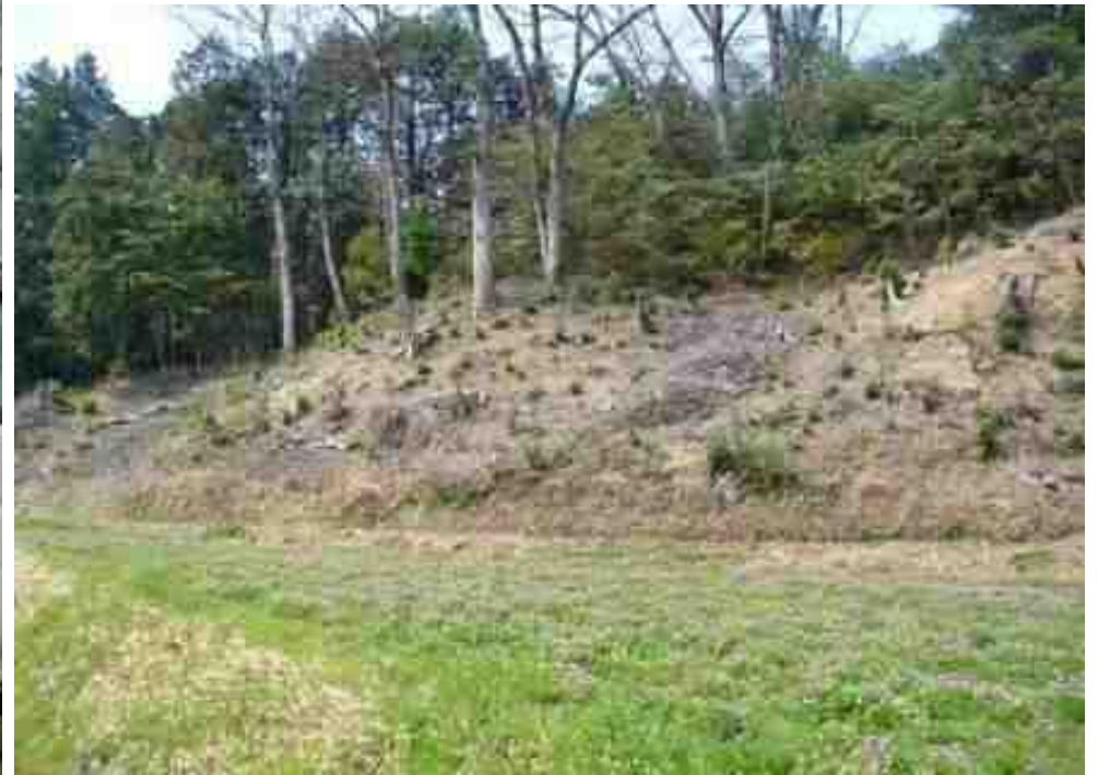
■ 緩衝帯の設置
