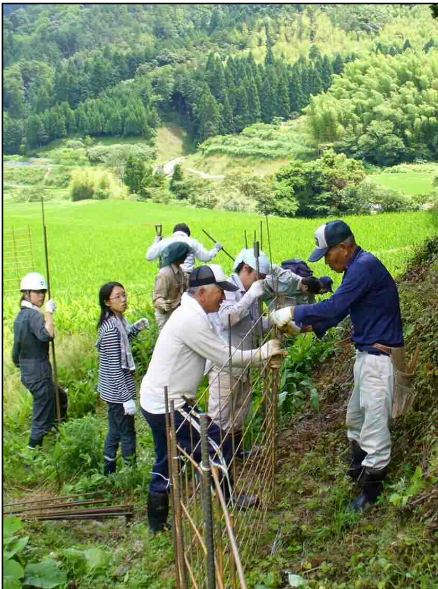
▲ワイヤーメッシュ柵の設置
