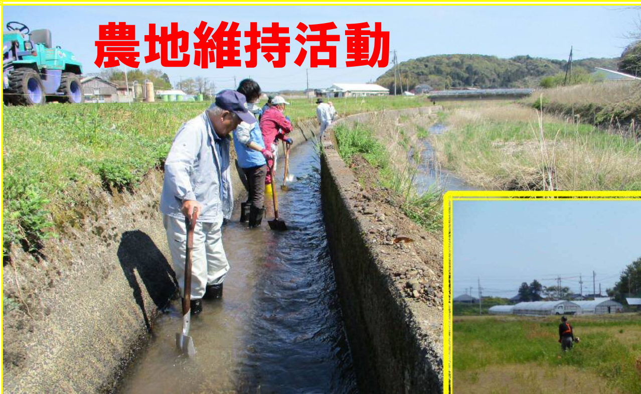
水路の泥上げ
