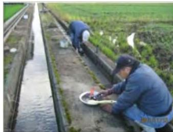
自主施工による目地補修
