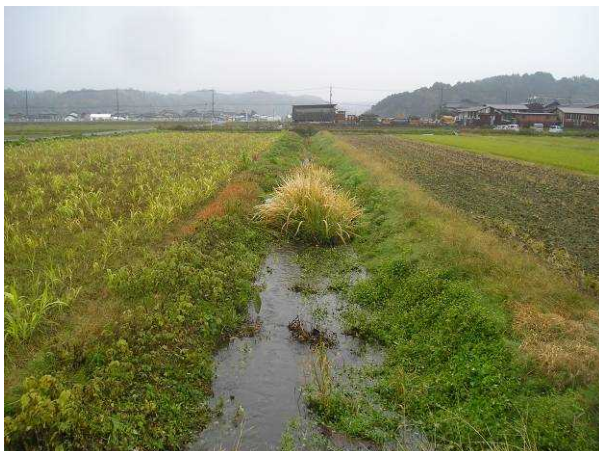
排水路の通水阻害例
