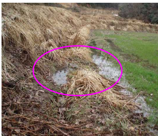
用水路の通水阻害例 (泥上げがされていないため、下流域への通水を阻害し圃場内に水が流れ込んでいる。)
