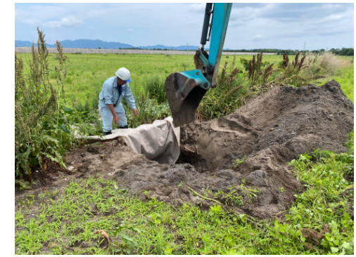
陥没補修
