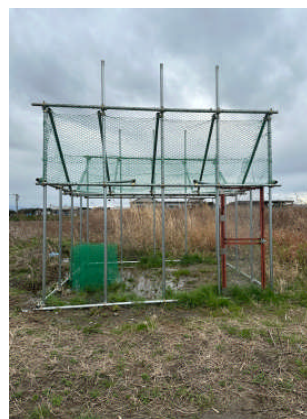
箱罾補修(途中経過)
