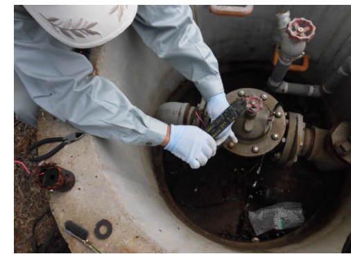
電磁弁修理
