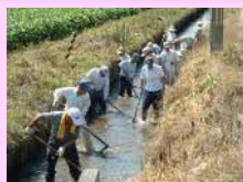
水路の泥上げ
