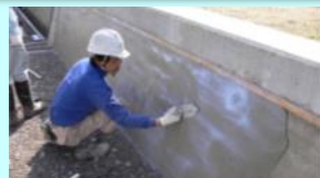
老朽化した水路壁のコーティング
