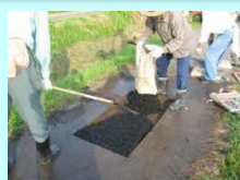
農道の部分補修
