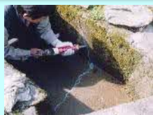
水路のひび割れ補修
