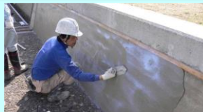
老朽化した水路壁のコーティング
