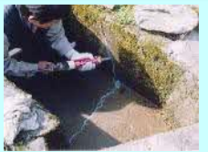
水路のひび割れ補修
