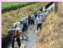
水路の泥上げ
