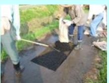
農道の部分補修
