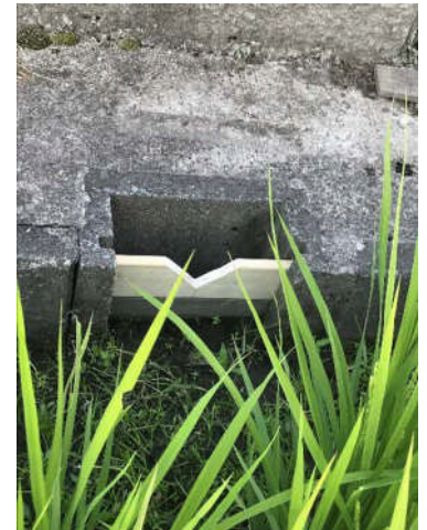
自作排水調整板(設置)
