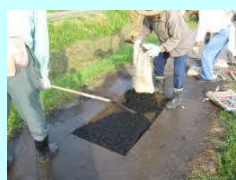
農道の部分補修
