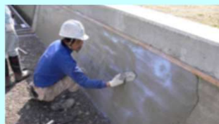
老朽化した水路壁のコーティング
