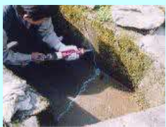
水路のひび割れ補修
