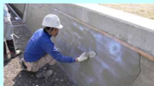
老朽化した水路壁のコーティング
