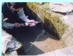
水路のひび割れ補修
