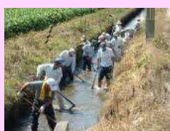
水路の泥上げ
