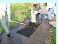
農道の部分補修
