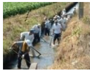
水路の泥上げ
