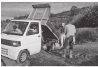
農道コンクリート舗装(直営施工)
