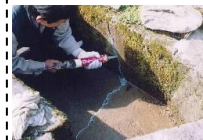
水路のひび割れ補修
