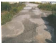
農道の窪みの補修
