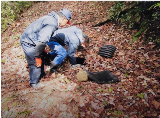
山腹水路(埋設ポリエチレン管路)の点検掃除
