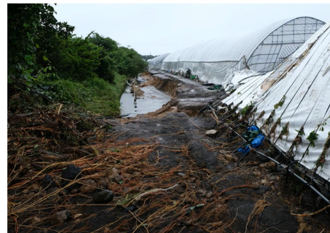
令和3年7月の豪雨による決壊 (鳥取県東伯郡北栄町)
