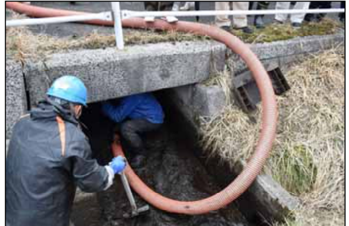
道路下に堆積した土砂を吸引
