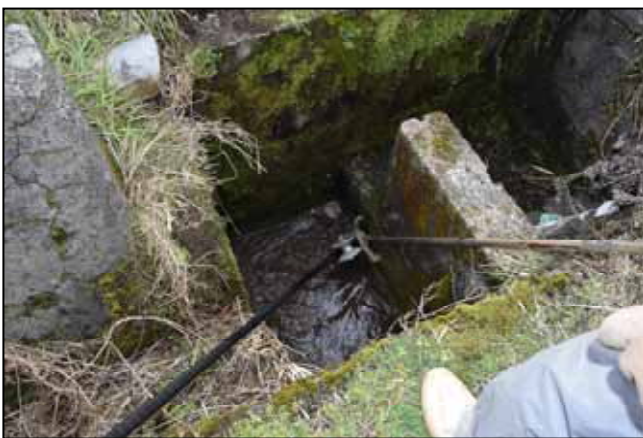
下流管口から高圧洗浄ホースを挿入
