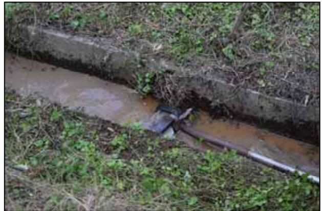
洗浄により暗渠排水内の泥が洗い流れている様子
