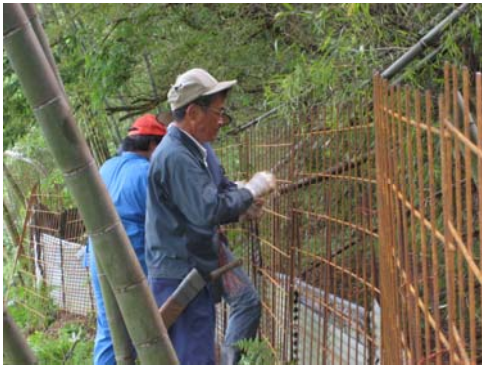
イノシシ防護柵の設置
