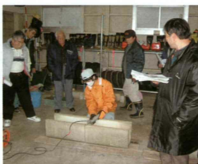
グラインダーによる古い目地の除去
