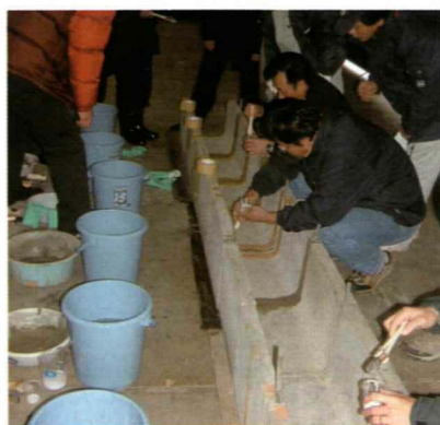
プライマーの塗布
