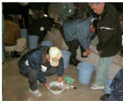
繊維モルタルとプライマーの混練
