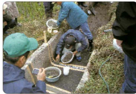
補修作業の実習状況
