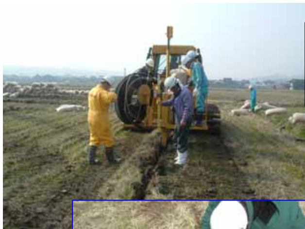
地下パイプのベスト・ドレーン工法による施工写真(50, 75)
