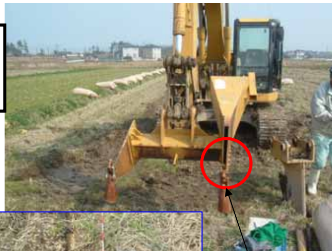
補助孔の施工写真(径10cm)
